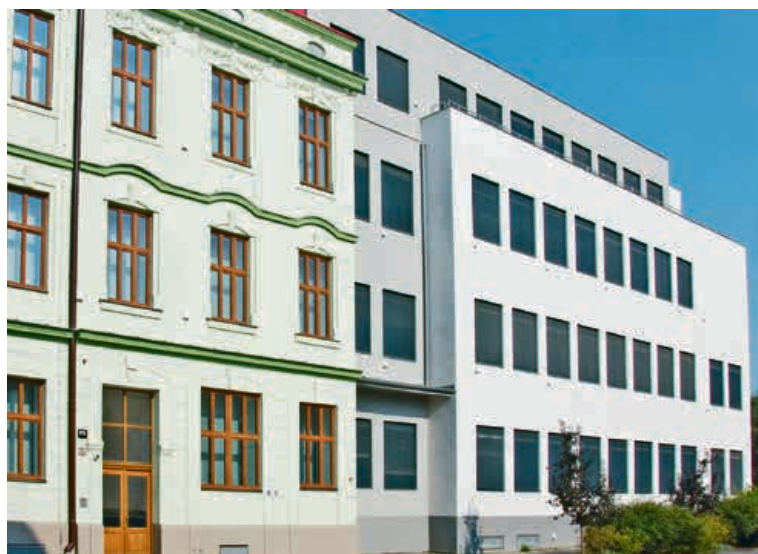
■ Budova bývalé střední školy se po rekonstrukci 2022 – 2024 změnila na Alšovku – novou budovu Jihomoravského muzea.
