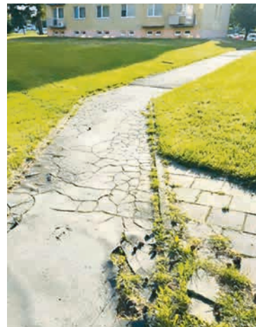
■ Část chodníku na ulici Aninská před opravou a po ní.
